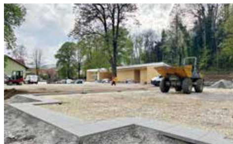
Die umfangreichen Bauarbeiten im Rintpark gehen in die finale Phase
