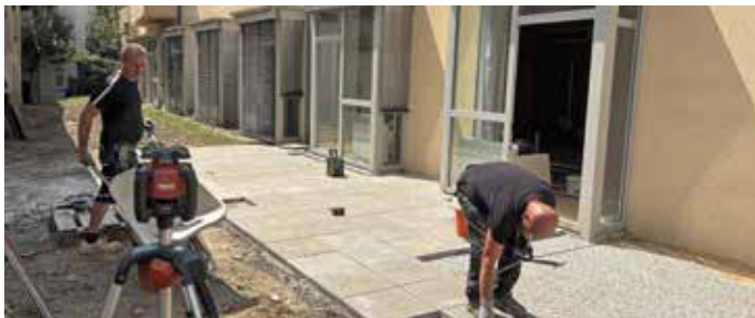
Die Arbeiten am neuen Seniorentageszentrum gehen planmäßig voran
