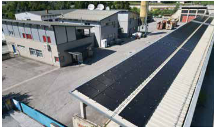
Die PV-Anlage mit 108 kWp, der 96kWh-Speicher und das Notstromaggregat machen den Wirtschaftshof fast autark
